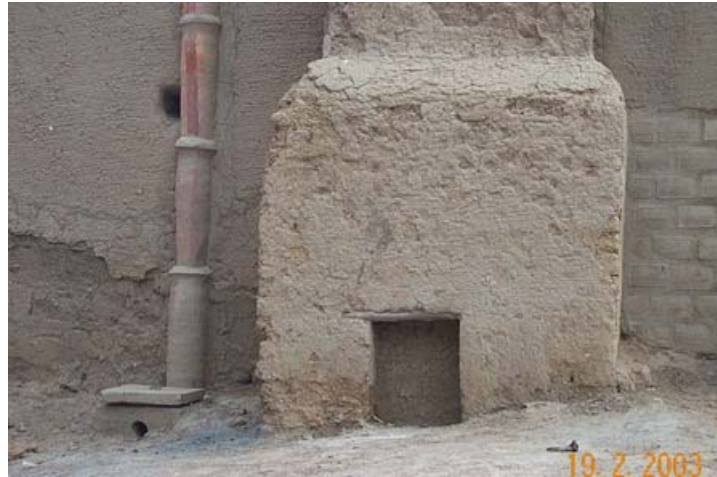
fig 6 : socle et trou par lequel les excréta sont évacués de la toilette
