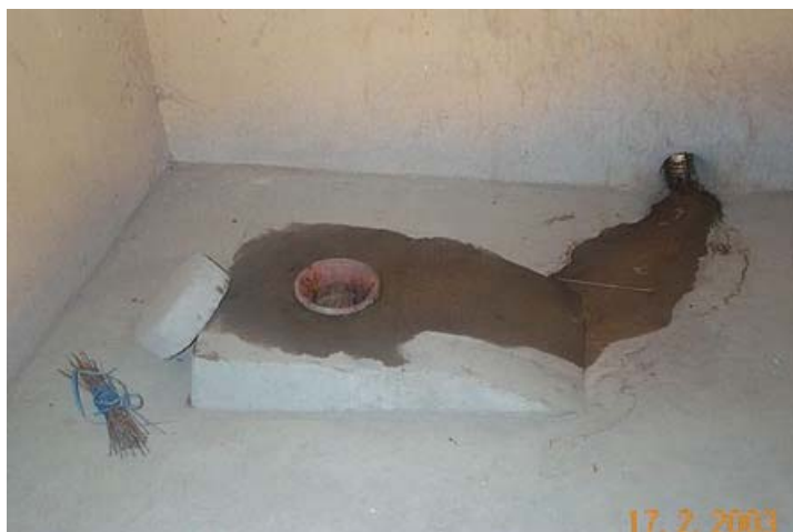
fig 5: trou de défécation sur plan incliné et sortie des urines vers la rue.
